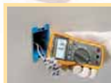
Reparación o mantenimiento
