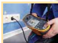
Comprobación de instalaciones eléctricas
